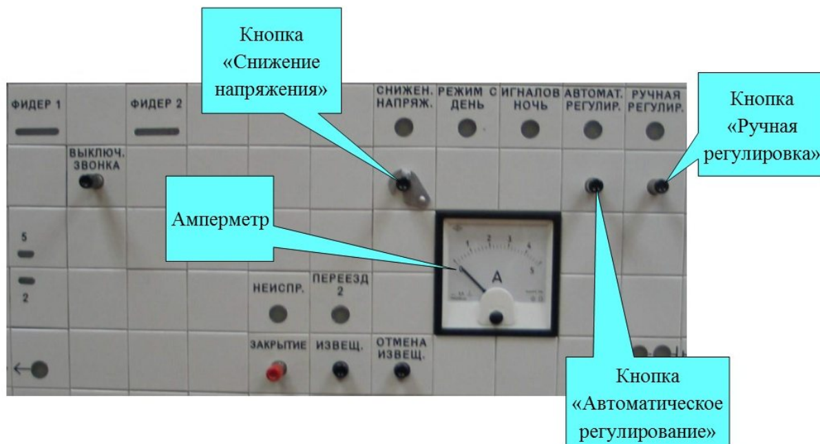
Рис. 23. Фрагмент пульт-табло с амперметром
