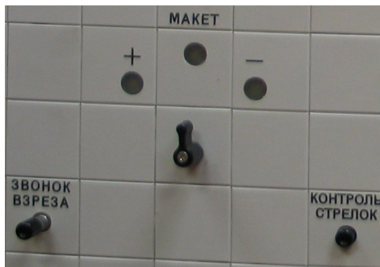
Рис. 27. Фрагмент пульта-табло с рукояткой макета
